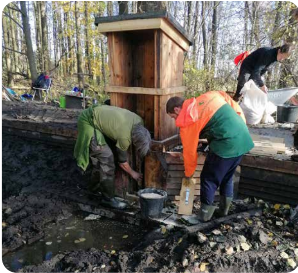
Das Ablassbauwerk (Mönch) wurde traditionell aus Holz gefertigt.
